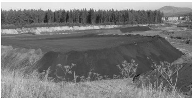
Рис. 1. Формирование массива техногенных песков на участке нарушенных земель
