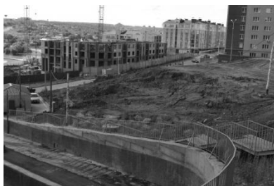
Рис.6. Этот же оползень. Общий вид.
