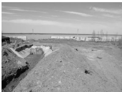
Рис.3. Овраг 2. Засыпанное устье с приемным колодцем
